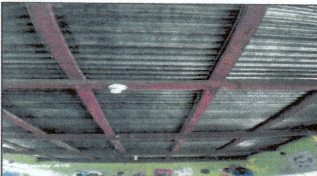
Foto 3: Sustitución de elementos de fijación
