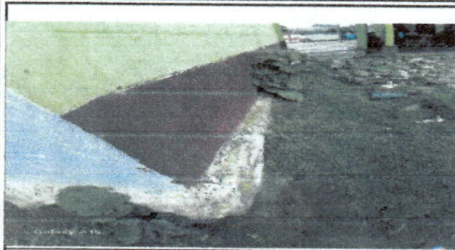
Foto 13: Reparación de plancha de concreto
