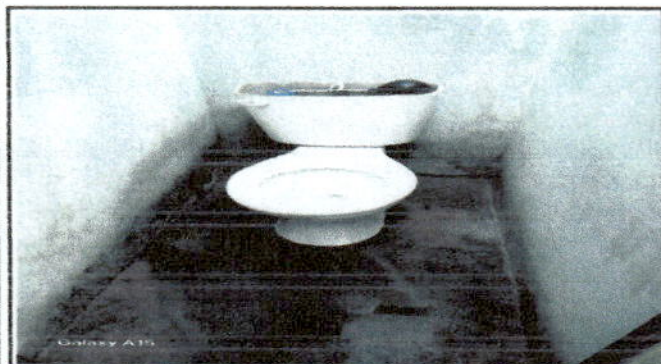
Foto 9: sustitución de accesorios para inodoro inodoro
