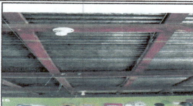
Foto 14: Reparación de cableado eléctrico
