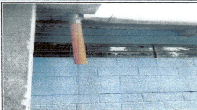
Foto8: sustitución de bajada de agua pluvial tubo pvc 3"
